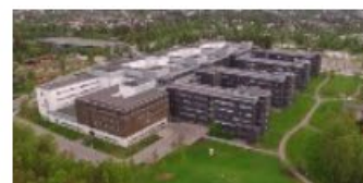
Akershus universitetssykehus HF Kreft- og somatikkbygg
