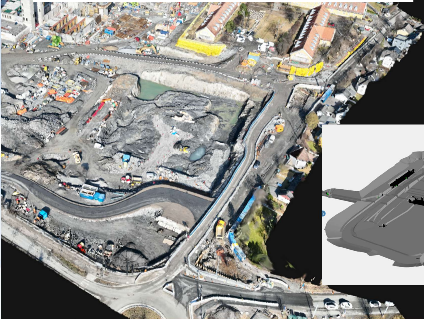
Dronebilde av byggegrop VDS/TS og grøfter og kummer i Sinsenveien
