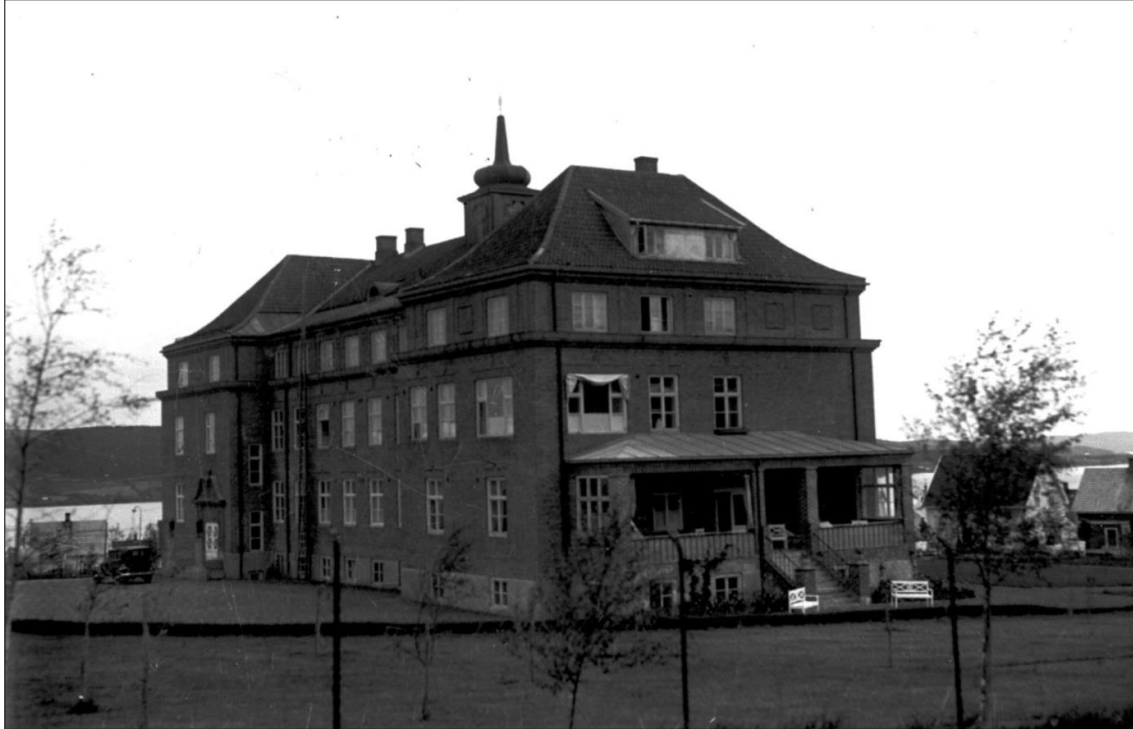
Figur 4-13: Sykehuset i Gjøvik 1925 (bygning senere revet) (DigitaltMuseum, 2020)
