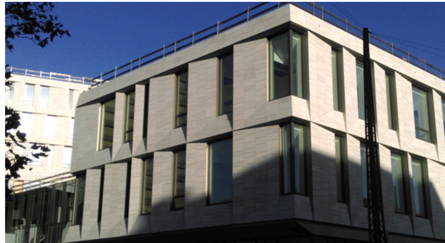
Skyggevirking på fasade med vinklede partier Referansefasade Rigshospitalets Nordfløy, København
