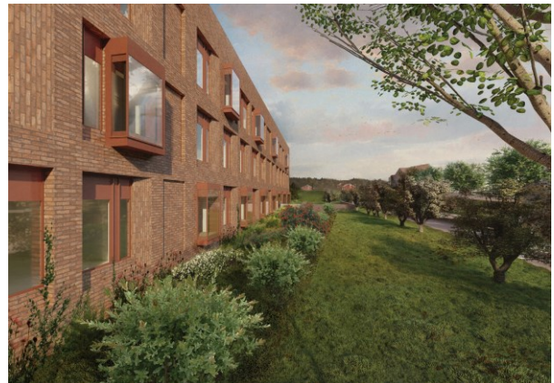
Figur 2. Fasade bygg N mot øst, Nye Rikshospitalet
