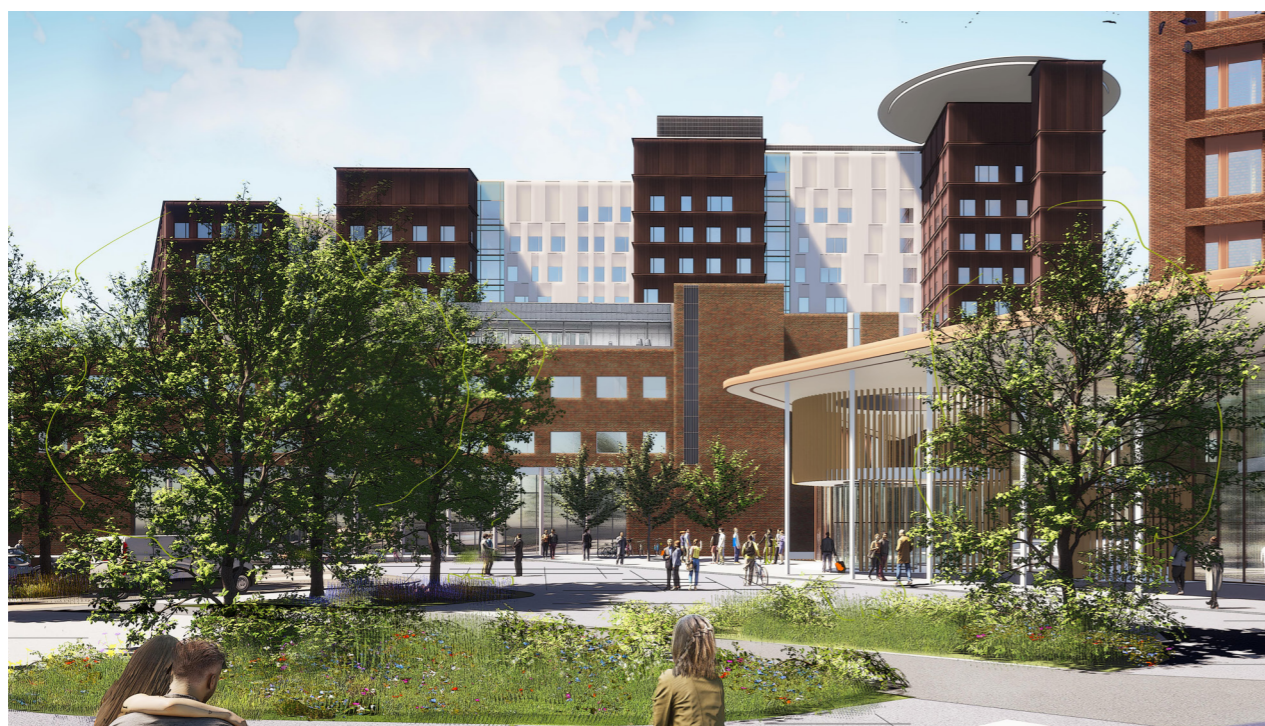
Figur 4.17 - Bygg J sett fra øst - Lamellen fremstår med mørke. Mellomliggende areal har lyse flater
