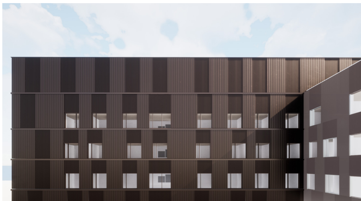
Figur 4.16 - Bygg J, lamellene kledd med metallkledning
