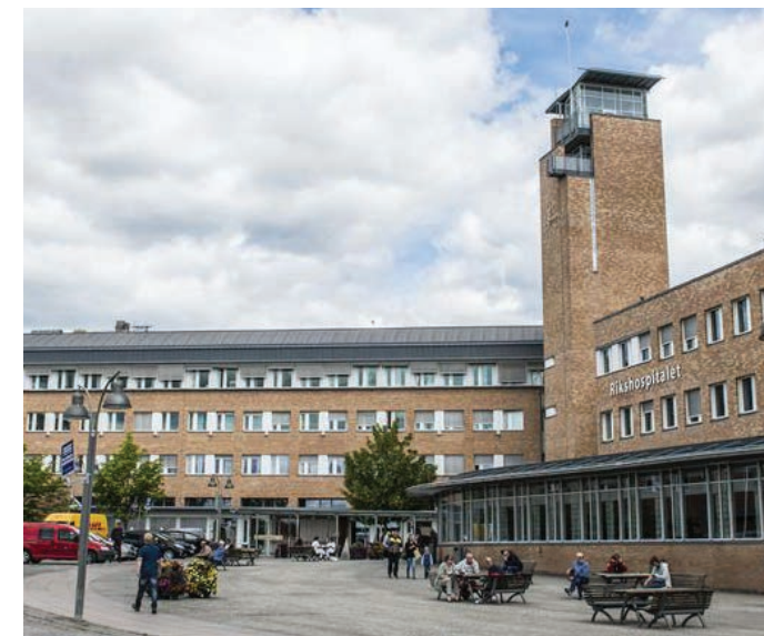
Figur 3.9 Inngangsplassen og tårnet på Rikshospitalet.
