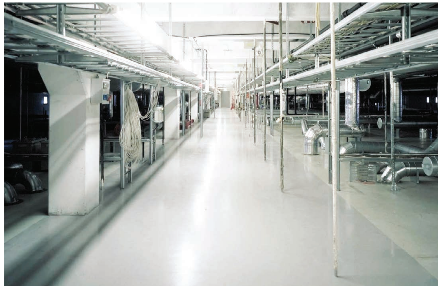
Figur 8.9 Teknisk mellometasje (TME) Ref. Rikshospitalet / RATIO arkitekter.
