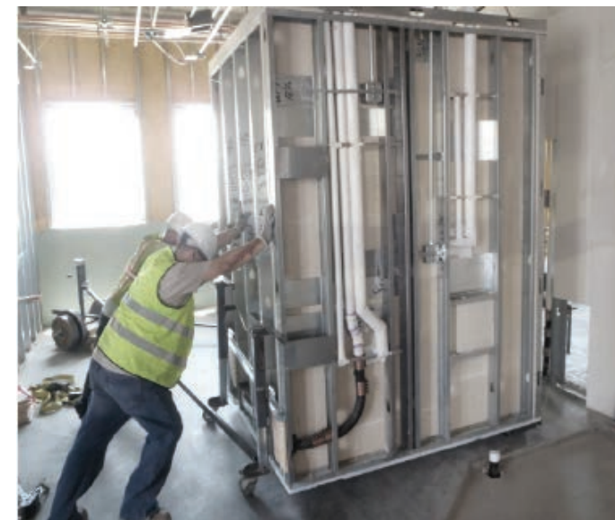
Figur 8.11 Eksempel prefabrikkert bad.
