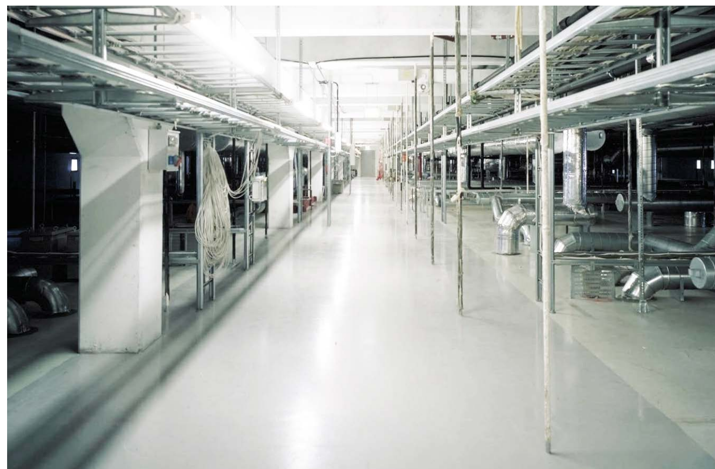
Figur 8.9 Teknisk mellometasje (TME) Ref. Rikshospitalet / RATIO arkitekter.
