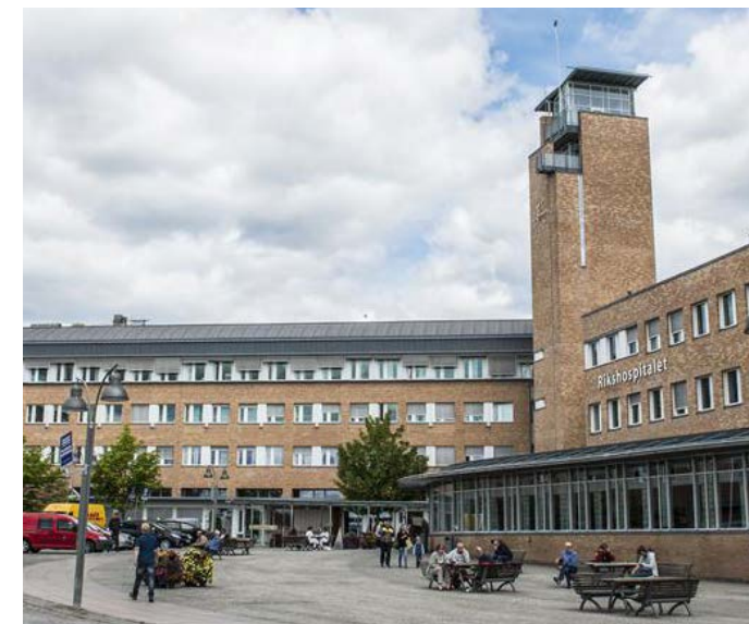
Figur 3.9 Inngangsplassen og tårnet på Rikshospitalet.
