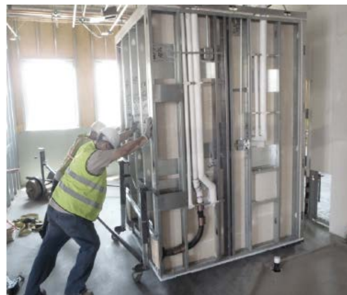
Figur 8.11 Eksempel prefabrikkert bad.
