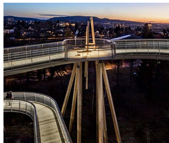
Figur 5.28 Eks. på gangbro til marka. Ref. Stovnerårnet/LINK
