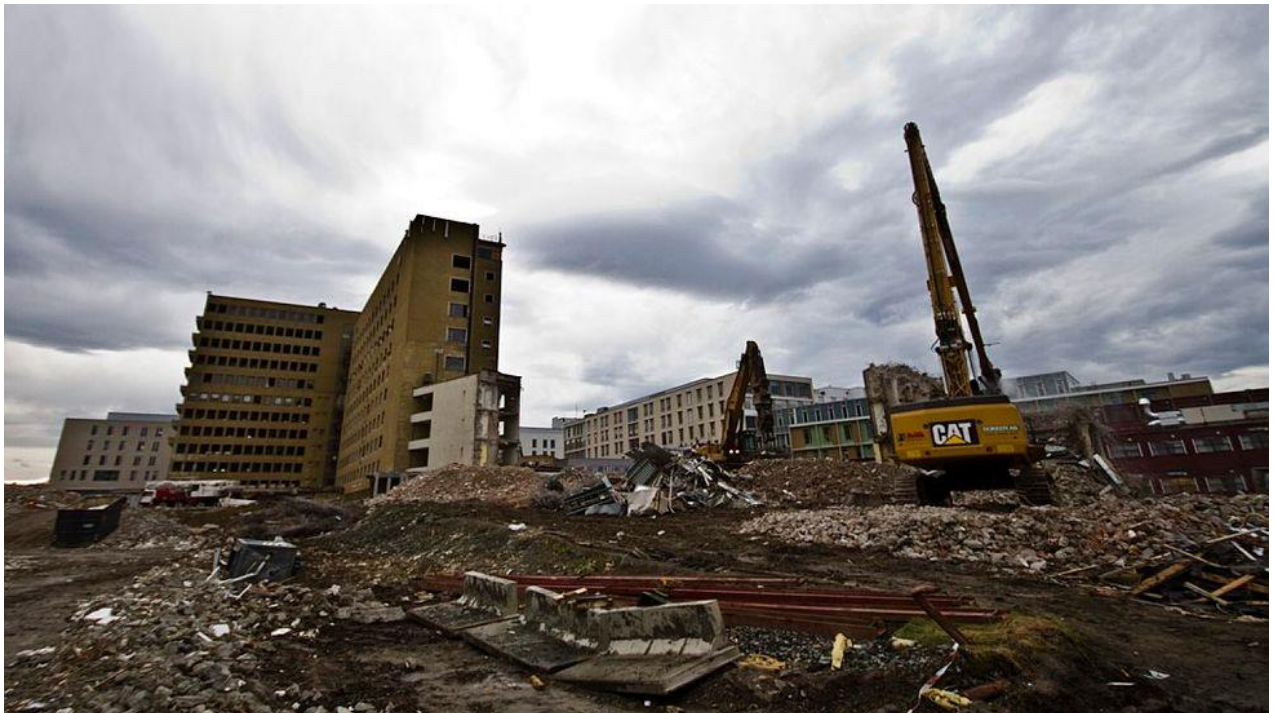
Figur 2: Riving av den gamle høyblokka St.Olavs hospital
