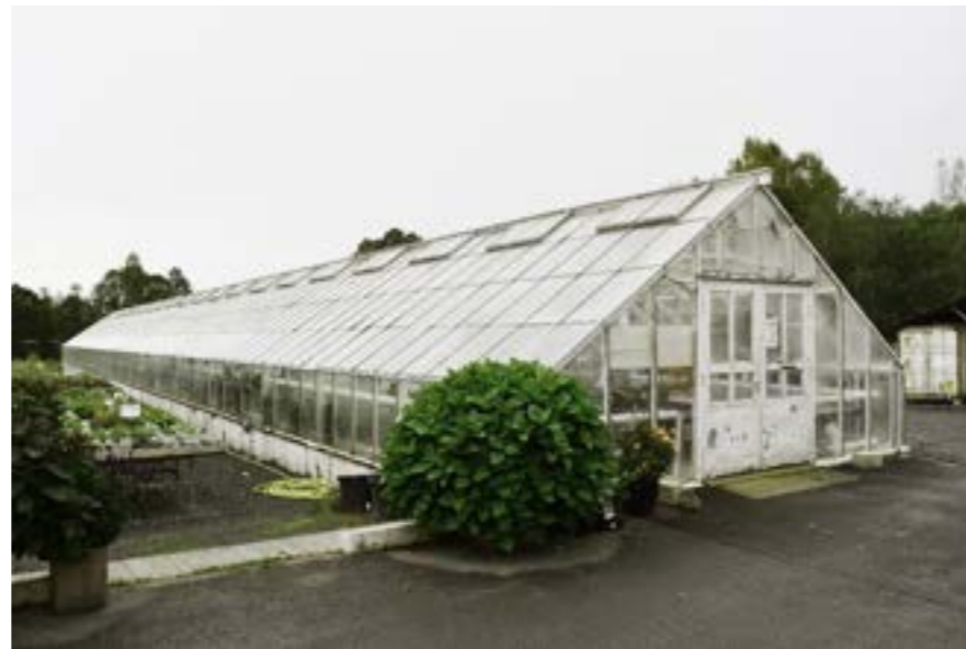
Figur 2.9 Situasjonsbilde av verneverdig drivhus
