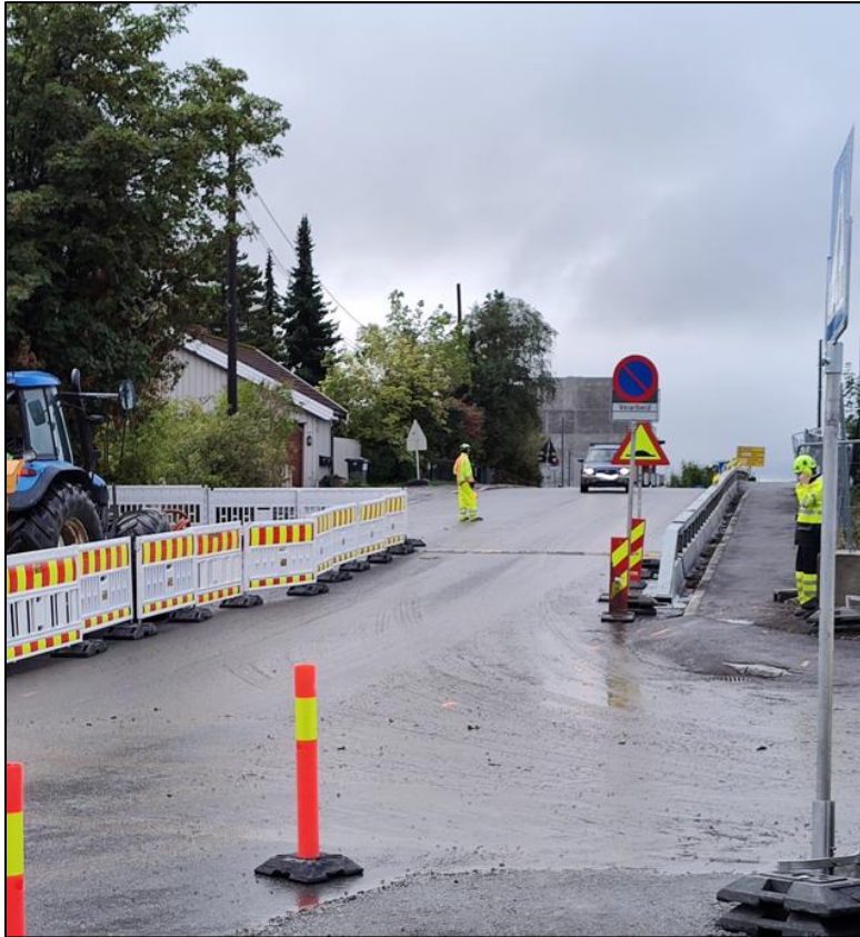
Etablert midlertidig trafikksituasjon
