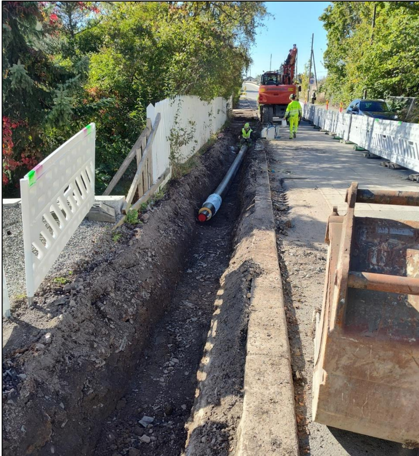
Provisorisk vannforsyning under etablering.
