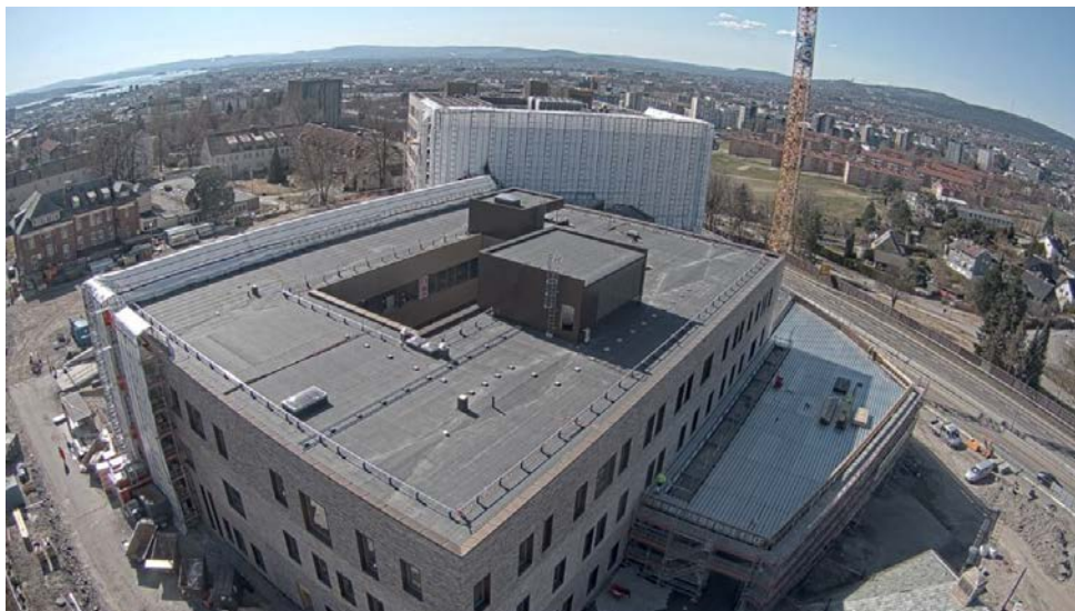
Bilde 7: Oslo storbylegevakt, bilde fra 20. april 2022
