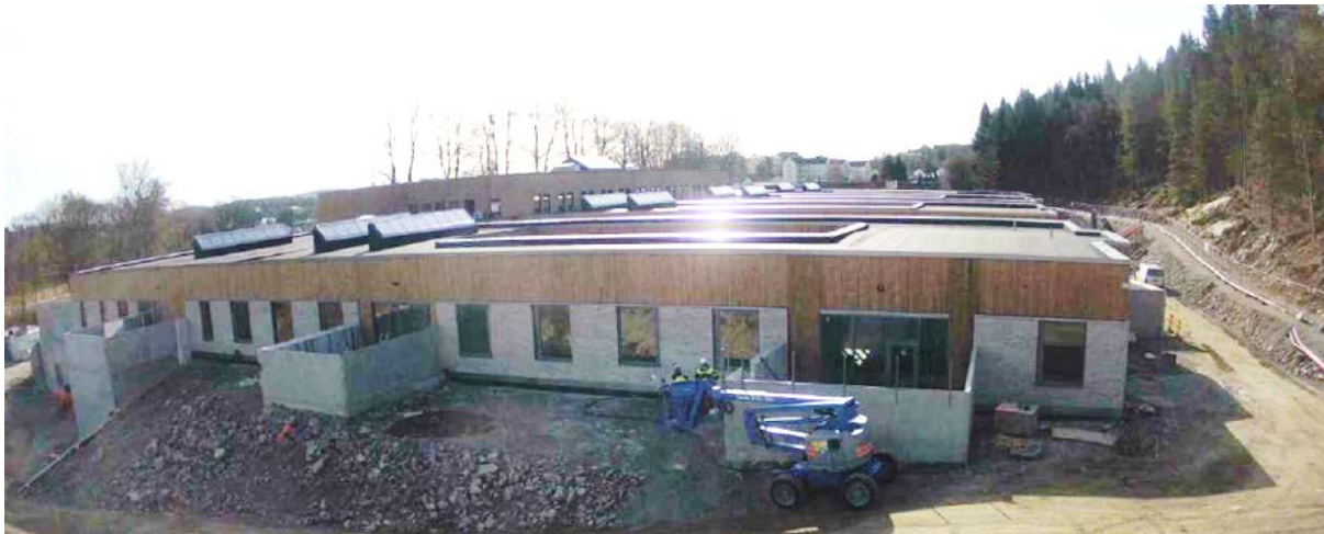
Bilde 3: Foto fra byggeplassen, Nybygg psykisk helsevern i Kristiansand, april 2022.
