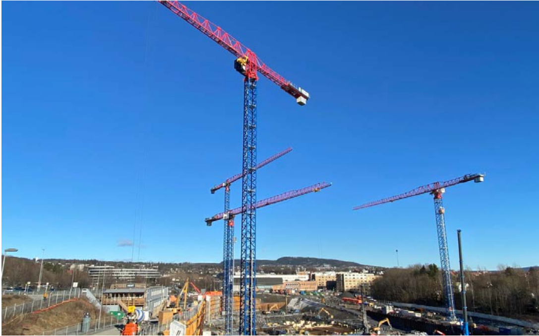
Bilde 9: Foto fra byggeplass Livsvitenskapsbygget, mars 2022
